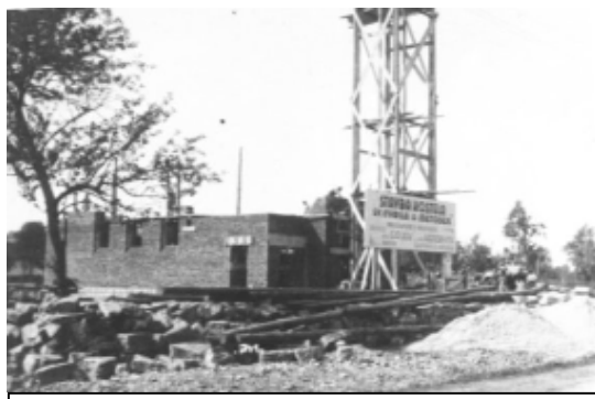
Stavba se rozbíhá...
